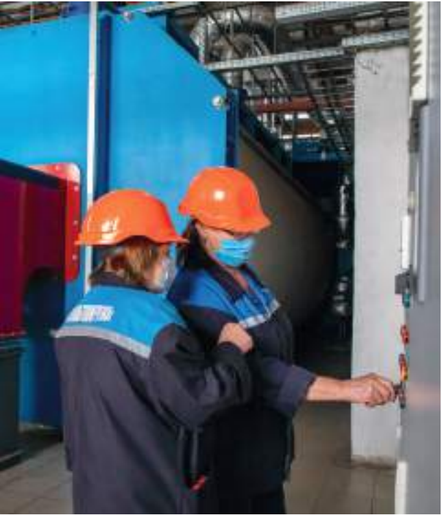
Технічний стан водопровідної інфраструктури
