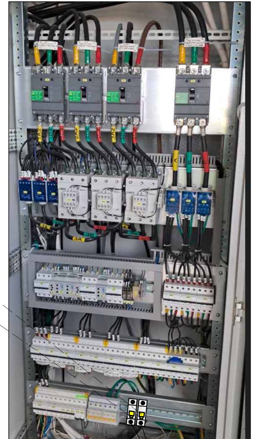
Додаткові однополюсні автоматичні вимикачі, Асті 9 іС60, 40 А
